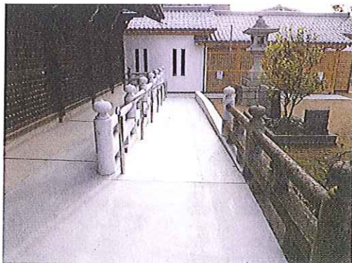
新設されたスロープ
